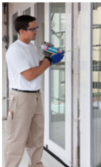
Bei der Fugenabdichtung von Fenstern sollte man den richtigen Umgang mit PU-Schaum beachten.
