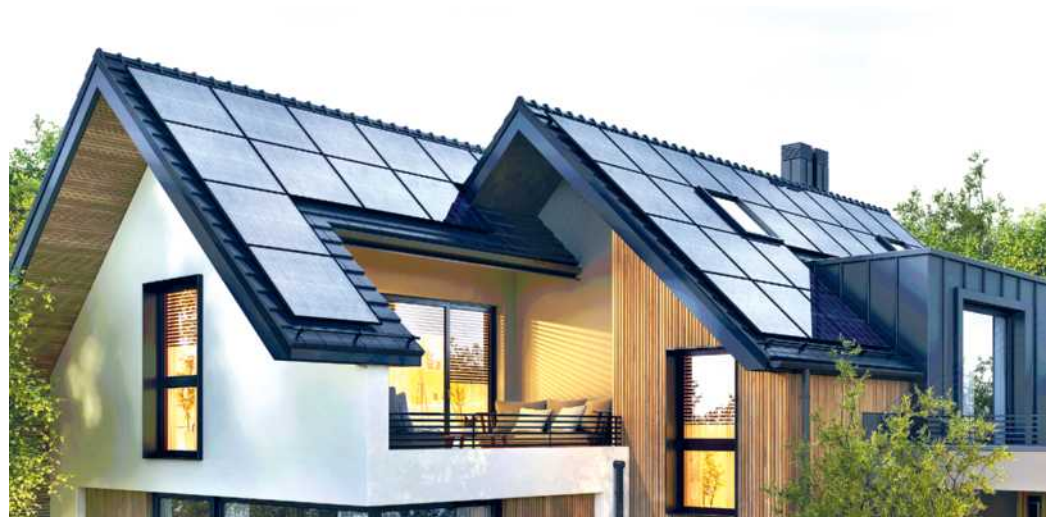
Ein regelmäßiger DachCheck von Innungsbetrieben des Dachdeckerhandwerks beugt Schäden vor, die oft unbemerkt bleiben und schützt vor kostspieligen Folgeschäden.
