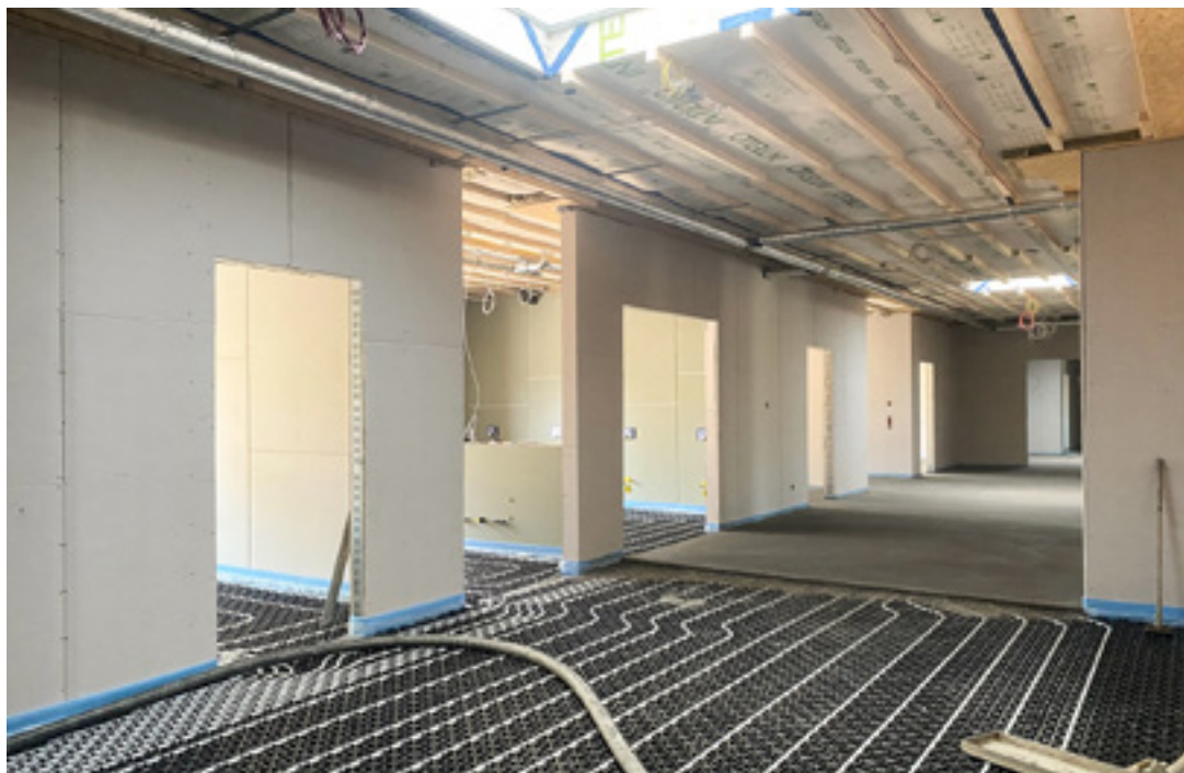
Im Neubau der KiTa „Wachtelnest“ wird in diesen Tagen der Estrich eingebaut. Zuvor waren die Leitungen der Fußbodenheizung verlegt worden.
