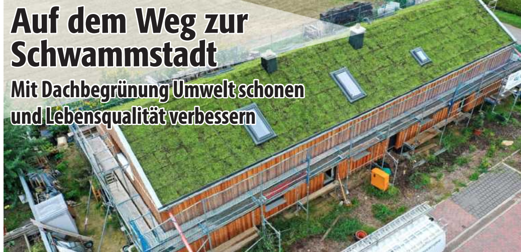
Im Rahmen eines Neubaus oder einer Dachsanierung lassen sich Dachbegrünungen mit überschaubarem Zusatzaufwand umsetzen.
