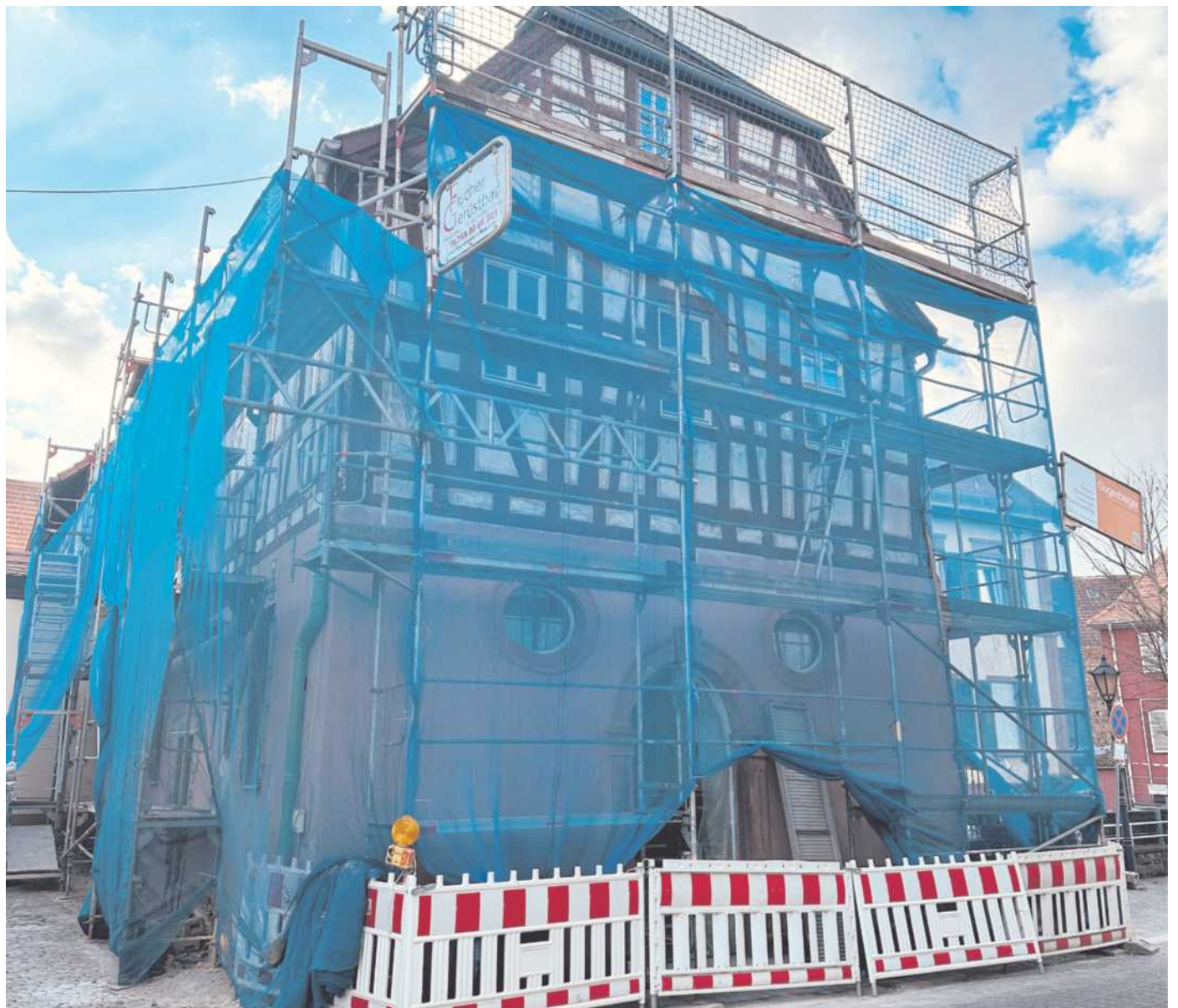
Die Fassadensanierung am historischen Rathaus konnte mittlerweile zu großen Teilen abgeschlossen werden – nun geht es an den Innenausbau.
