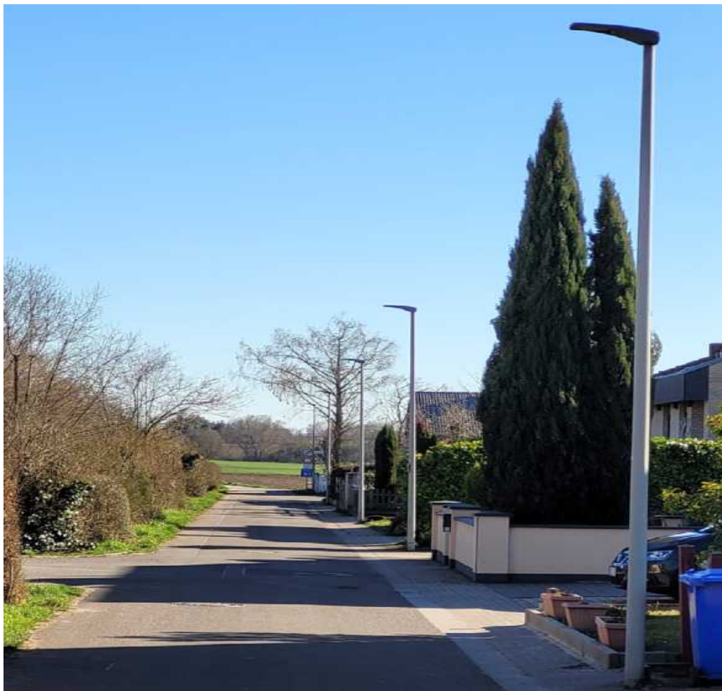
Moderne LED-Leuchten tragen in der Verbandsgemeinde Monsheim – wie hier in Hohen-Sülzen – erheblich zu Energie- und Kosteneinsparungen bei. Foto: Stefan Radmacher
